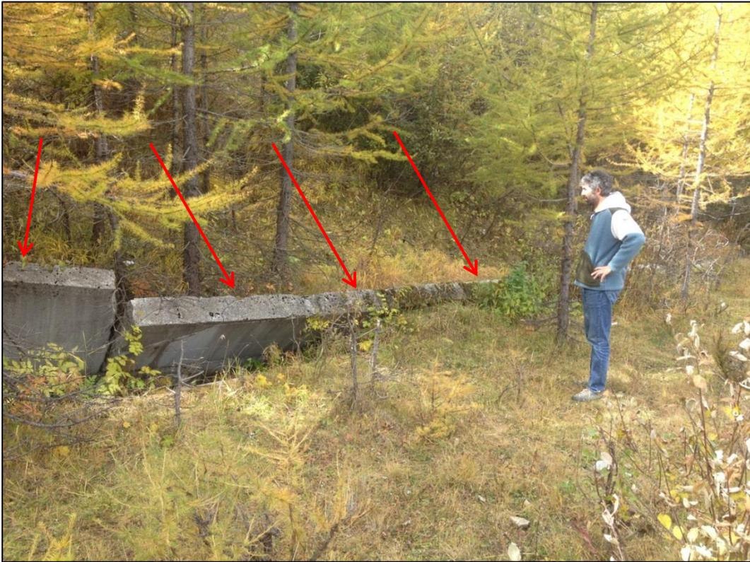
Figura 6. Immagine del muro di contenimento della pista da bob fortemente danneggiato da forze spingenti del versante
