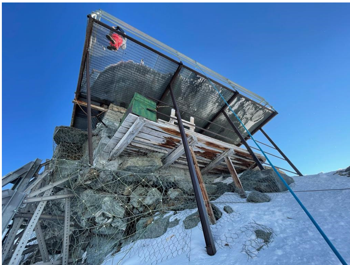
Fig.13 - Vista generale della struttura che sostiene la Capanna
