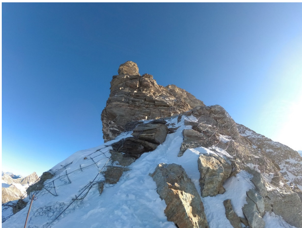
Fig. 10 - Dettaglio 2 reti addossate su blocchi che sostengono la piazzola di servizio.
