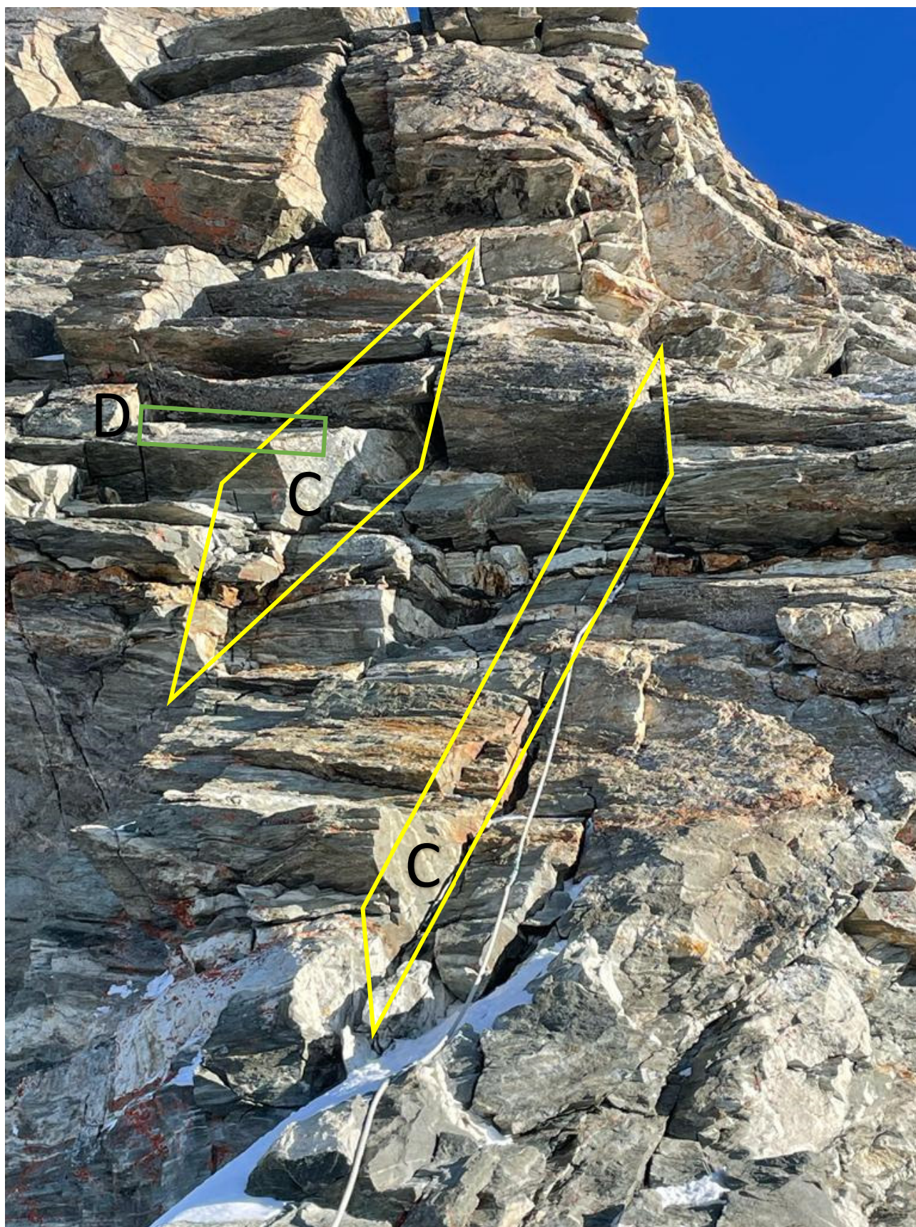
Fig. 26 - Dettaglio stazione geomeccanica 3 con i principali set di discontinuità rilevati
