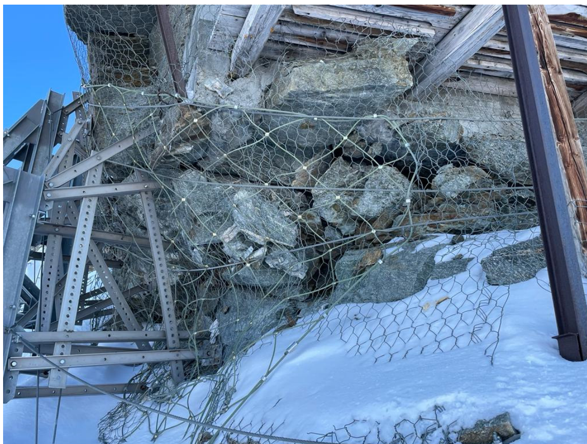
Fig. 14 - Dettaglio blocchi consolidati con effetto "scavernamento" degli stessi
