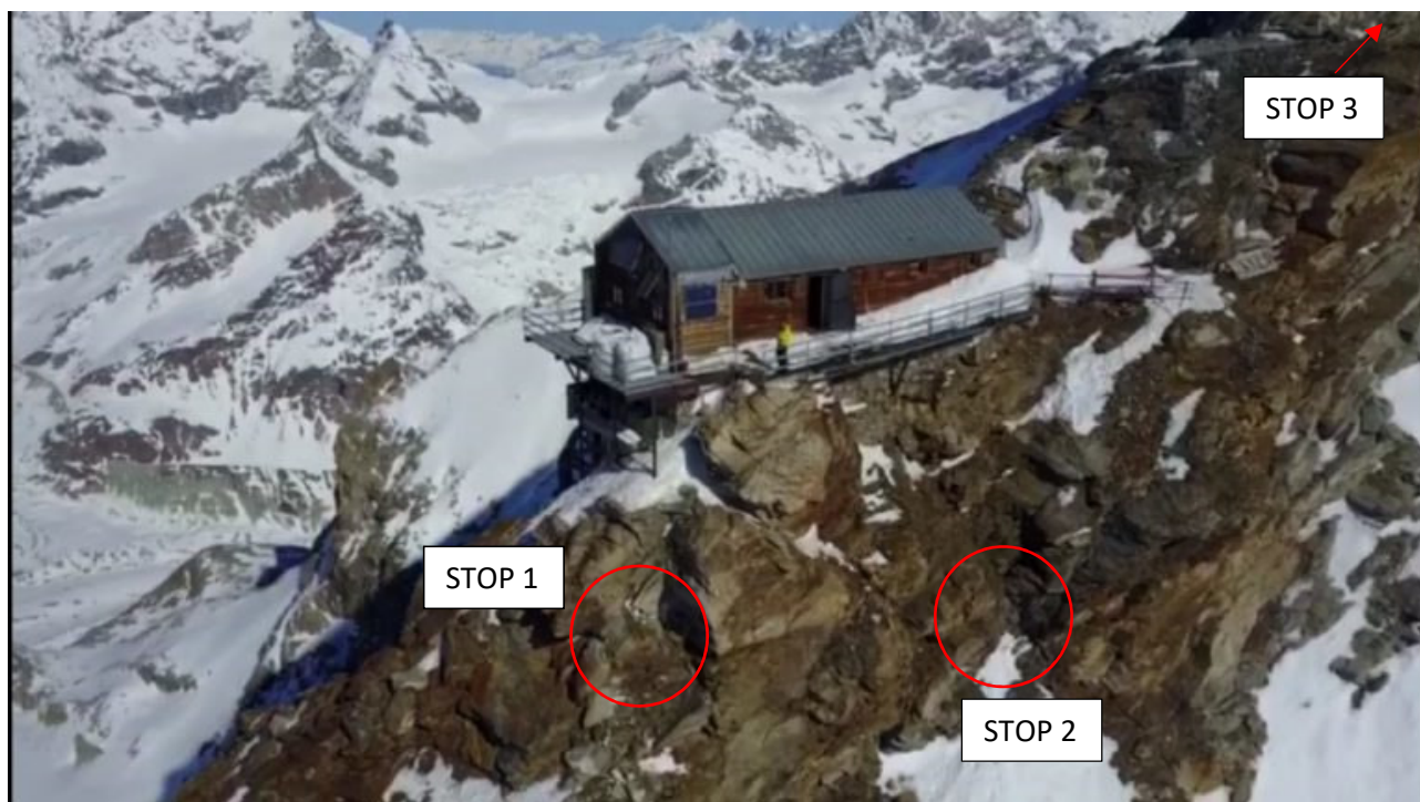
Fig. 29 – Ubicazione delle stazioni geomeccaniche rispetto alla Capanna Carrel.
