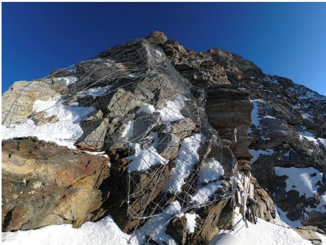
Fig. 9 - Dettaglio 1 reti addossate su blocchi che sostengono la piazzola di servizio.
