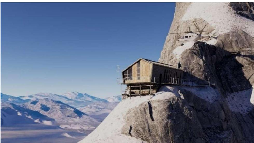
25. Soluzione con prospetto a due falde e pareti longitudinali strombate; prospetto SE rivestito in legno e prospetto SW con porzioni vetrate e porzioni piene in legno.
