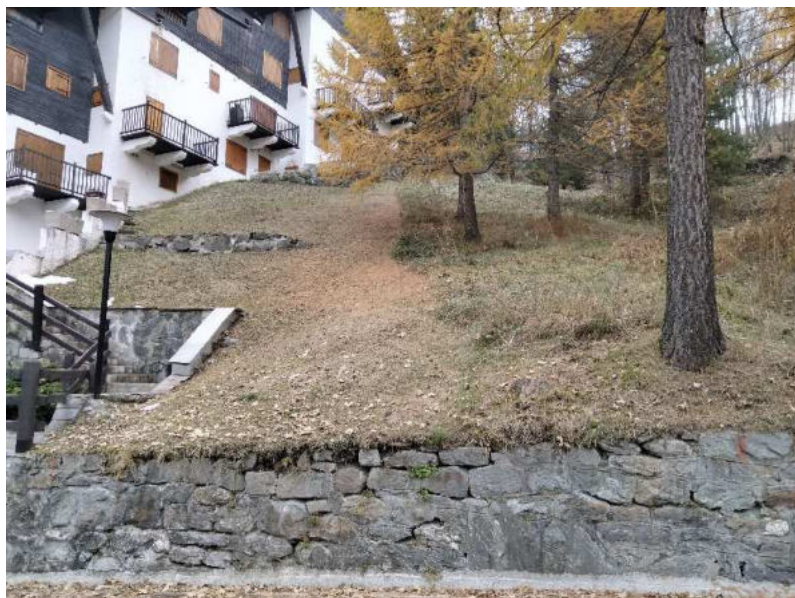
In primo piano mappale n. 786, in secondo piano mappale n. 347; a sinistra della scala proprietà pertinenziale condominiale
