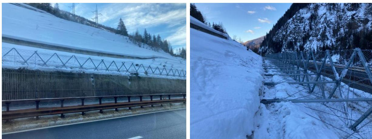
Esempio di installazione di strutture fermaneve a bordo strada (cantiere A22 del Brennero)
