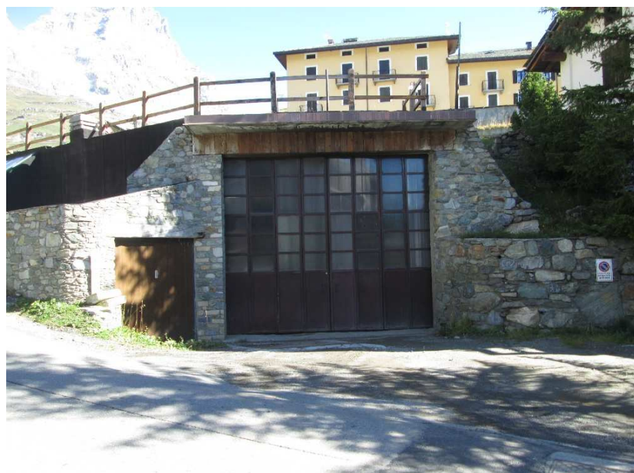
R2 – foto da Sud-ovest del mappale n. 745 Fg. 7, accesso autorimessa interrata “per il ricovero dei mezzi dell’attività di impresa edile”
