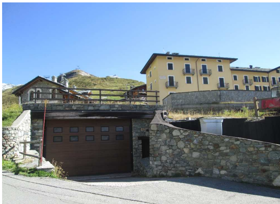
R1 – foto da Sud-ovest del mappale n. 986 Fg. 7, accesso autorimessa interrata “per il ricovero dei mezzi da neve che conducono all’attività (bar ristorante lungo le piste) e deposito materiali per l’attività stessa” Sulla destra R2 – foto parziale del mappale confinante n. 745 Fg. 7
